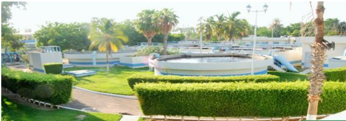
Figura 39. Ejemplo de una planta de tratamiento de aguas residuales
