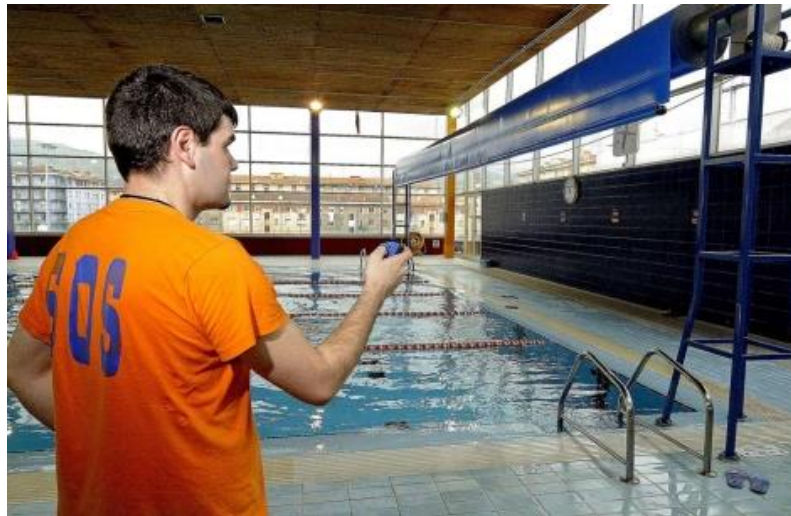
Figura 27. Activación de la lona para evitar la evaporación
